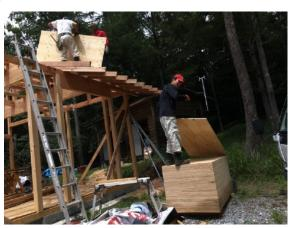
12日(日) 17℃ くもり晴れ 増田さんが 今日から参加するのであさ7時に佐久平駅までお出 迎え、二番列車の新幹線で到着。作業に合流しまし た。屋根作りと破風板を軒下に設置して、細かい作 業が続きます。午後からは西側に「ルーフィング材」 を張り始めて、傾斜が急なので角材のさんを60cm 間隔で横にビスで設置していきます。そこにルーフィ ングを貼ると、さんを設置して一段ずつ頂上に向け て登っていくのです。17時に作業終了して、今夜
